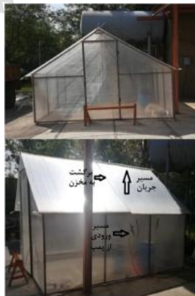
شکل ۱- سازه گلخانه تحقیقاتی که در آن سامانه سایه‌انداز دینامیکی تعبیه شده است. مجاری ورودی و خروجی سیال در بین صفحات پلی‌کربنات سقف در شکل نشان داده شده است.
