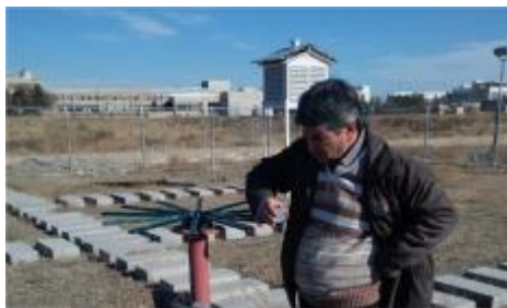
شکل ۲- ستون محل نصب گیرنده‌ها
