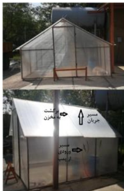
شکل ۱- سازه گلخانه تحقیقاتی که در آن سامانه سایه‌انداز دینامیکی تعبیه شده است. مجاری ورودی و خروجی سیال در بین صفحات پلی‌کربنات سقف در شکل نشان داده شده است.
